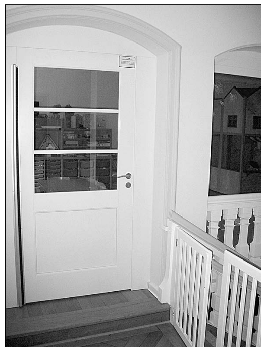
Umbaumaßnahmen im Bereich des 2. Rettungsweges
