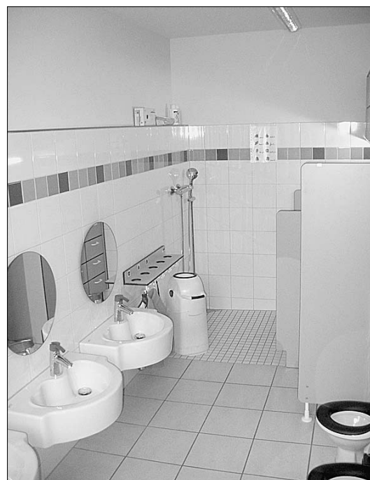
Neu geschaffener Sanitärbereich für Kinder bis drei Jahre
